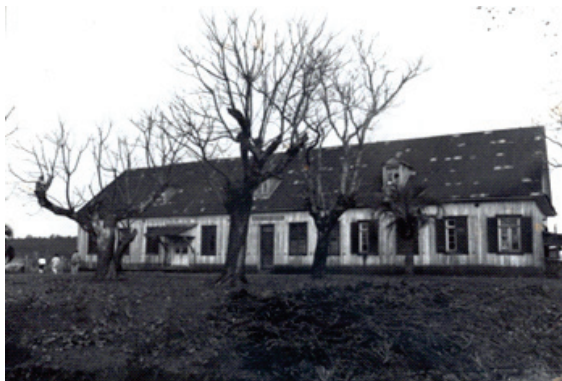
Figura 6: Prédio onde funcionou o Hospital Leonardo Cohen.
